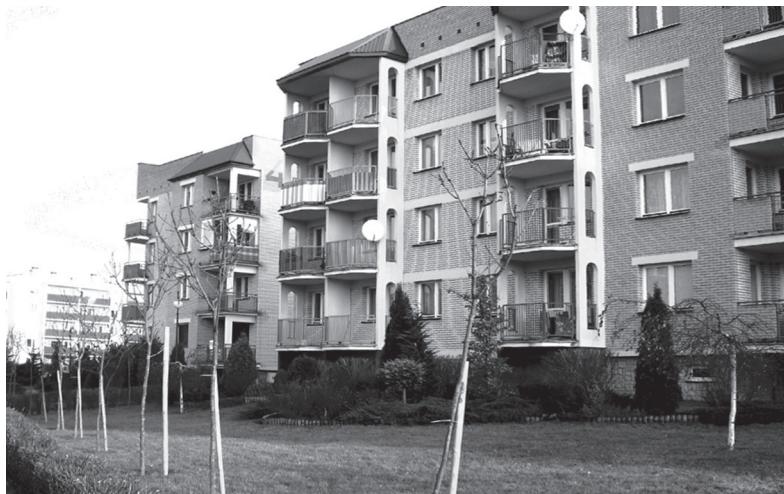
Fot. 1. Osiedle mieszkaniowe w Łomży
